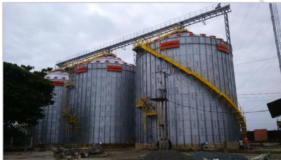
INDUSTRIA ARROCERA – LA PALMA 7,500 TM ALMACENAMIENTO EN SILOS
