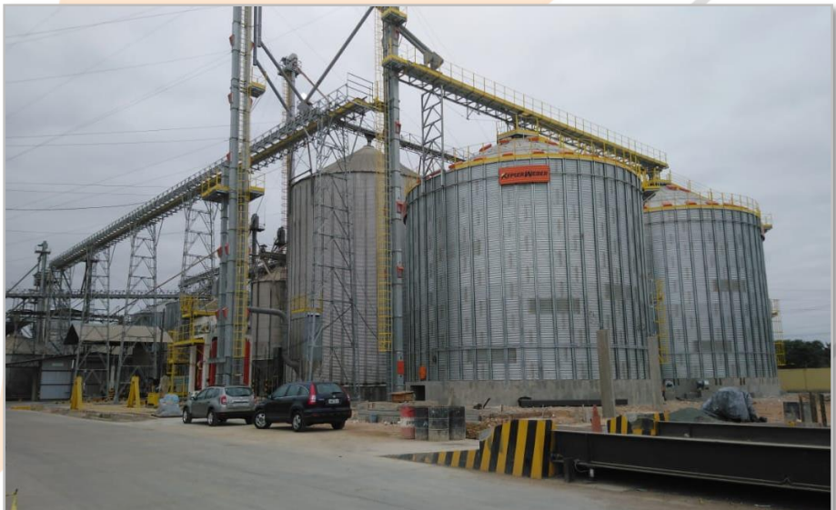
INDUSTRIA ALIMENTOS – AGRIPAC S.A. 7,200 TM ALMACENAMIENTO EN SILOS
