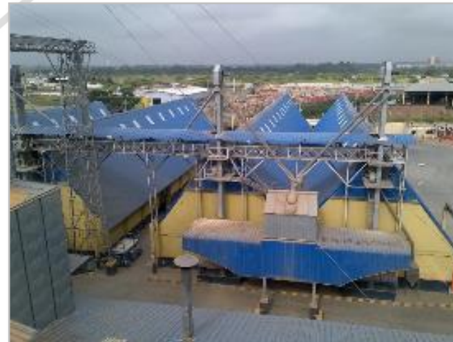
CENTRO DE ACOPIO - AGROINDUSTRIAS DAJAHU 20,000 TM ALMACENAMIENTO BODEGAS PLANAS
