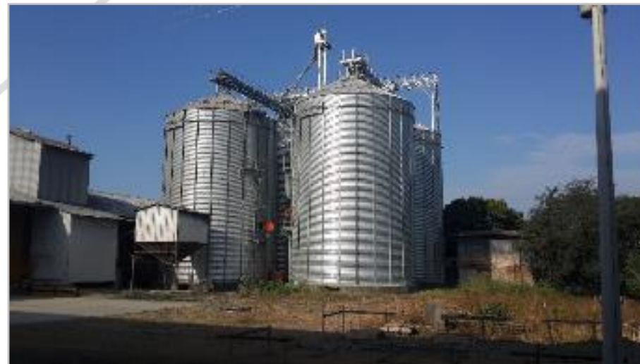
INDUSTRIA ARROCERA – INARMO 4,000 TM ALMACENAMIENTO EN SILOS
