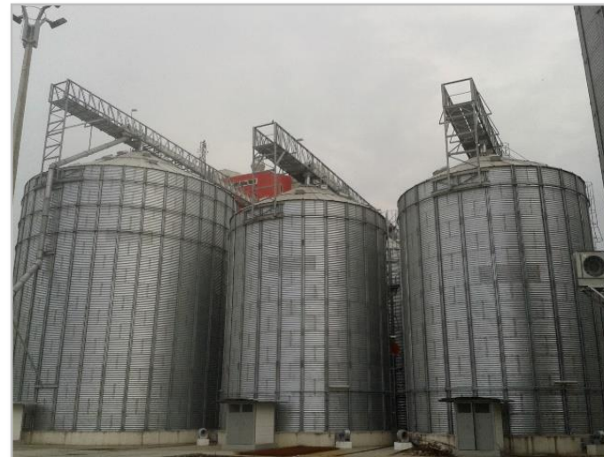
INDUSTRIA ALIMENTOS – PRONACA DURAN 17,000 TM ALMACENAMIENTO EN SILOS
