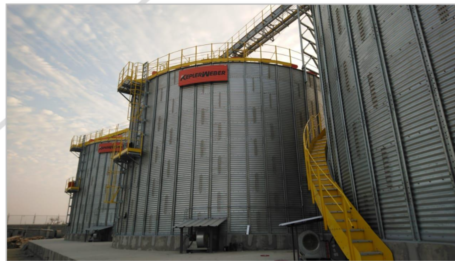
INDUSTRIA ARROCERA – INAROMEROSA 4,000 TM ALMACENAMIENTO EN SILOS
